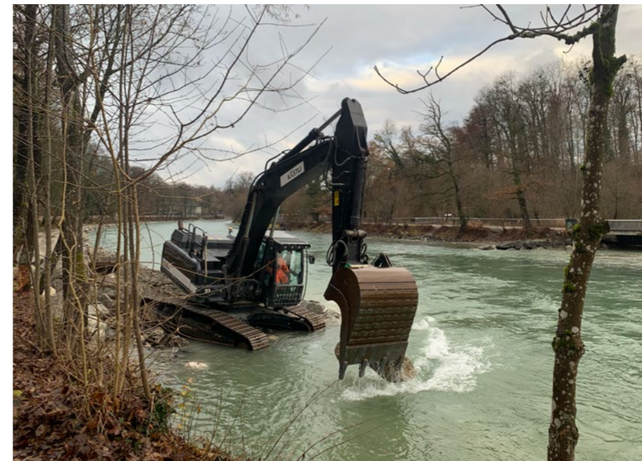
Bau des neuen Hochwasserschutzes. Foto: mr
