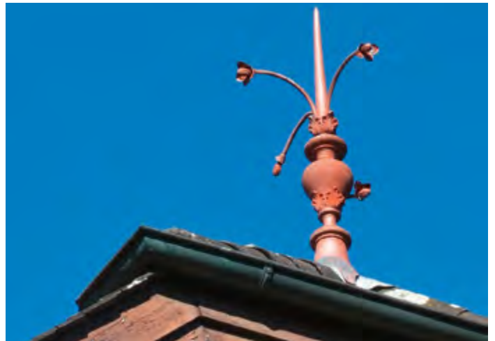
An der Schosshaldenstrasse.
