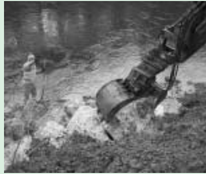
Blockwurf an der Aare – Präzisions-Arbeit!
