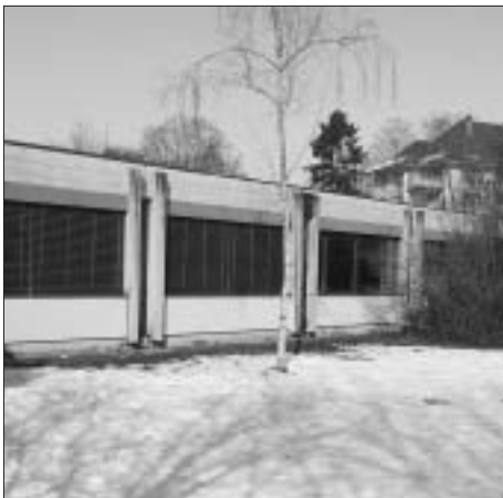
Der Erweiterungsbau von 1982 wird abgerissen.
