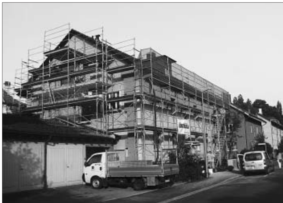
Totalsanierung mit neuen Fenstern und Wärmedämmung am Elfenaueweg.
