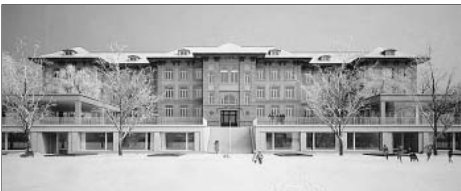
Das neue Schulhaus Kirchenfeld.
