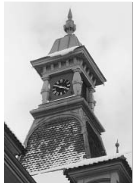
Bitzias, Burgfeld, Kirchenfeld, Laubegg, Sonnenhof, Manuel, Pavillon, Wittigkofen: Alle diese Schulhäuser liegen im Stadtteil IV. Zu welcher Schule gehört diese Uhr? (Lösung S. 23).
