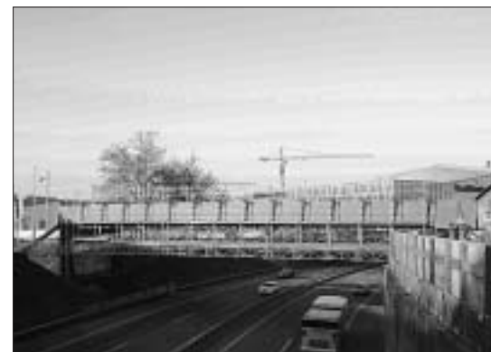
Was für ein Gebäude entsteht auf diesem Areal? Foto: pb
