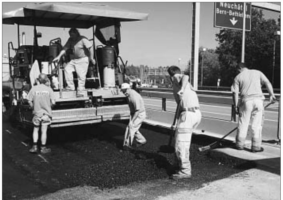
Die Arbeiten für die Gesamterneuerung der Stadttangente haben begonnen. Vor allem am Feierabend wird auch in unserem Stadtteil mit Mehrverkehr zu rechnen sein.
