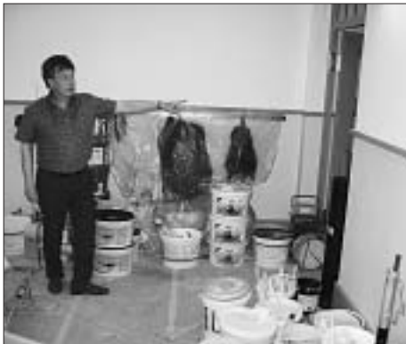
Urs Schütz führt durch die Baustelle im Laubegg-Schulhaus.
