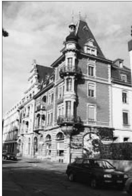
Ein Erker ist im Prinzip ein herausragender Bestandteil eines Hauses. Hier sowohl in die Strassenflucht hinaus, wie auch in die Höhe hinauf.
