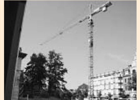
Kranführerkabine und Ausleger befinden sich 42 m über dem Grund.
