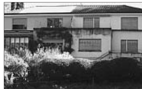
Nachbarn wehren sich: Andreas Wyss' Haus neben dem baufälligen Geisterhaus. Foto: kw
