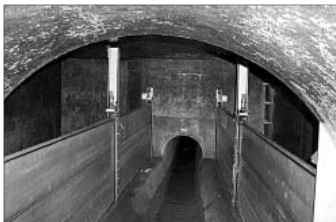
Regenentlastung unter der Autobahn bei der Bolligenstrasse.
