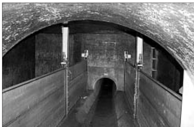
Regenentlastung unter der Autobahn bei der Bolligenstrasse.
