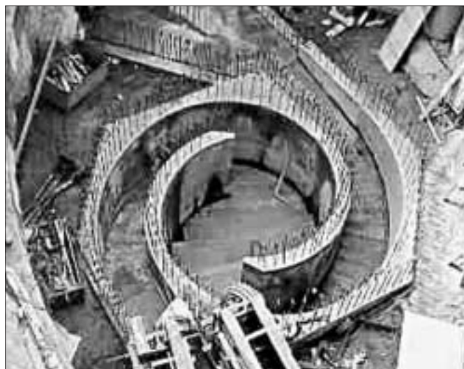
Wirbelfallschacht in der Länggasse im Bau (ähnlich wie der an der Surbekstrasse). (Fotos: Tiefbauamt, Bern)
