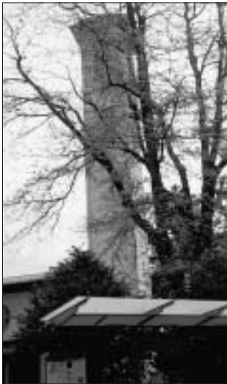
Ein Baldachin von Bärnmobil verdeckt den prachtvollen Glockenturm der Petruskirche. Was meint der Regierungsstatthalter?
