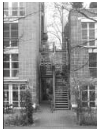
7 In welcher Siedlung befindet sich dieser Hauseingang?
