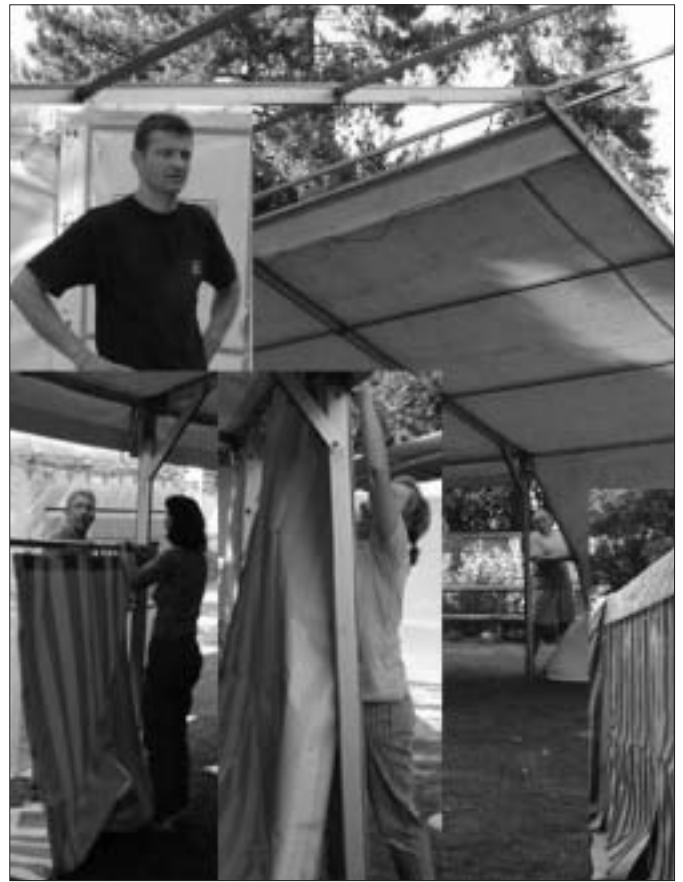
Das Zelt entsteht.
