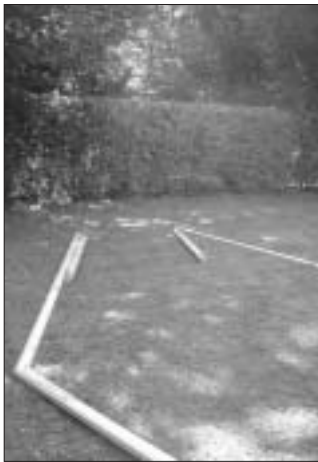
Grundsteine werden gelegt.
