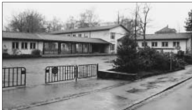
Das Jolimontschulhaus ist ein Bijou.
